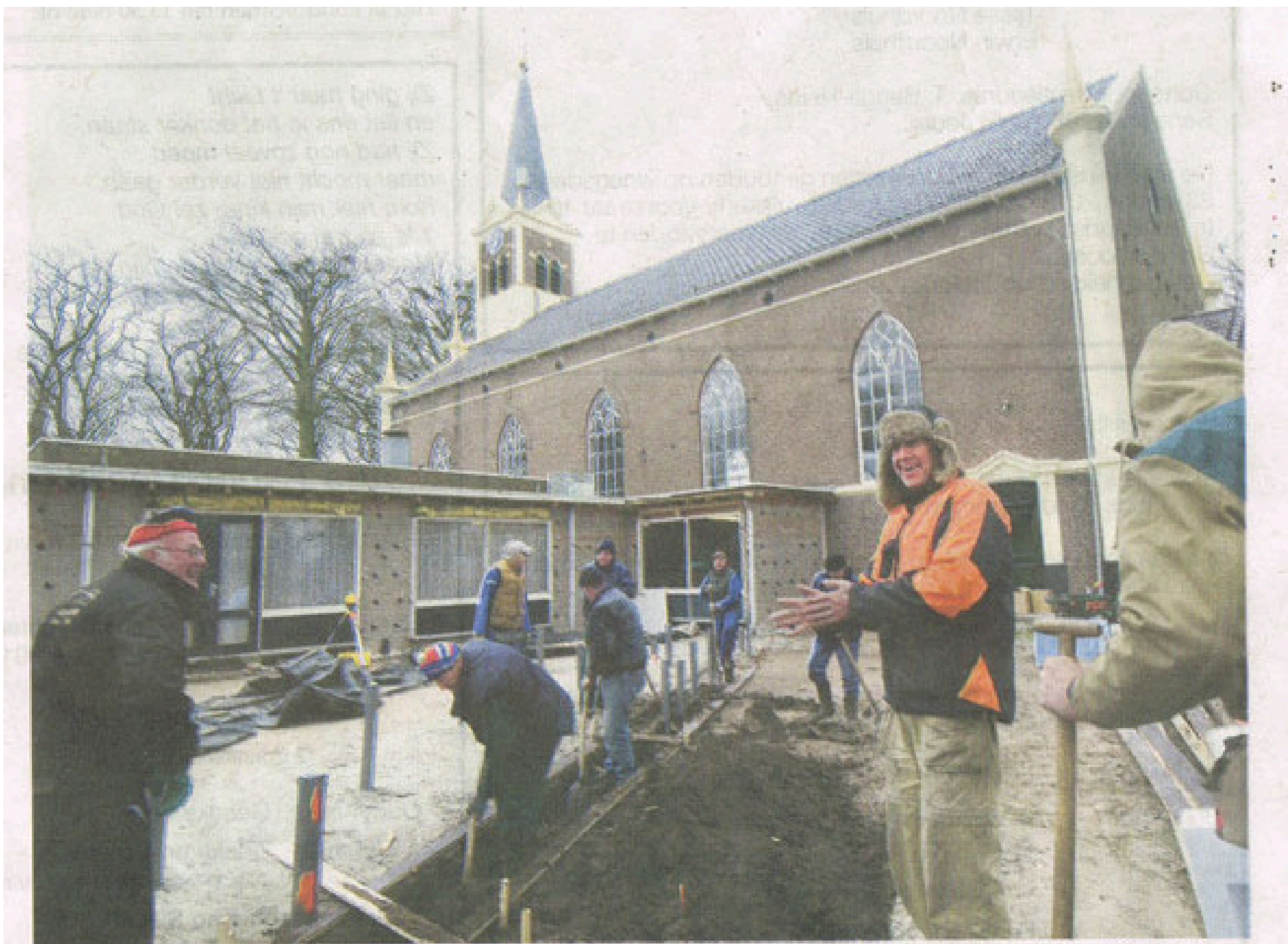
Een koude klus, afgelopen zaterdag voor de vrijwilligers bij de hervormde kerk aan het Heechsân in Eas- termar. De fundering voor het nieuwe gedeelte bij het gebouw moest worden gelegd. De buitenkant van de kerk is vorig jaar gerestaureerd. Vrijwilligers maken het werk nu af. Het pand wordt multifunctioneel. Ook verenigingen kunnen er straks terecht voor hun activiteiten. Foto: Marchje Andringa
